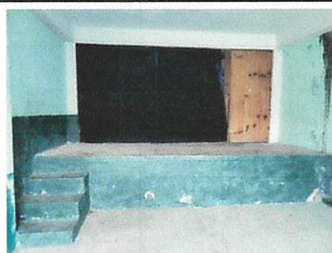
Foto 4: Pared para el fondo del escenario, ampliación de gradas y baranda para subir al mismo.
