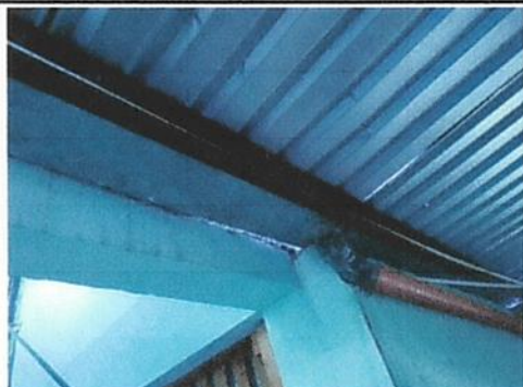
Foto 3: Reparación de canales.
