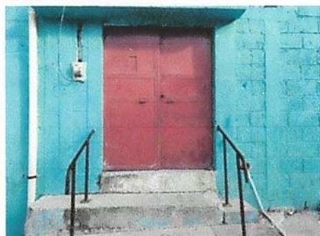
Foto 5: Pintura y reparación para puertas y barandas.
