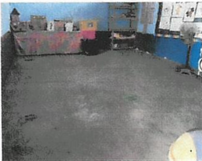
Foto 3: Piso para salón de clases 3
